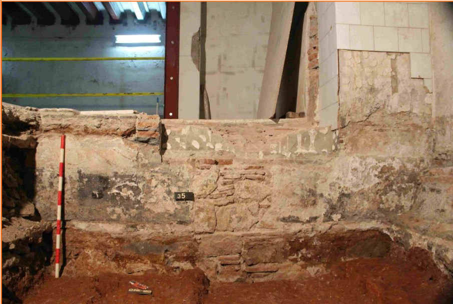
Foto 1. Vista final del parament del mur UE 35. C-ASC.
