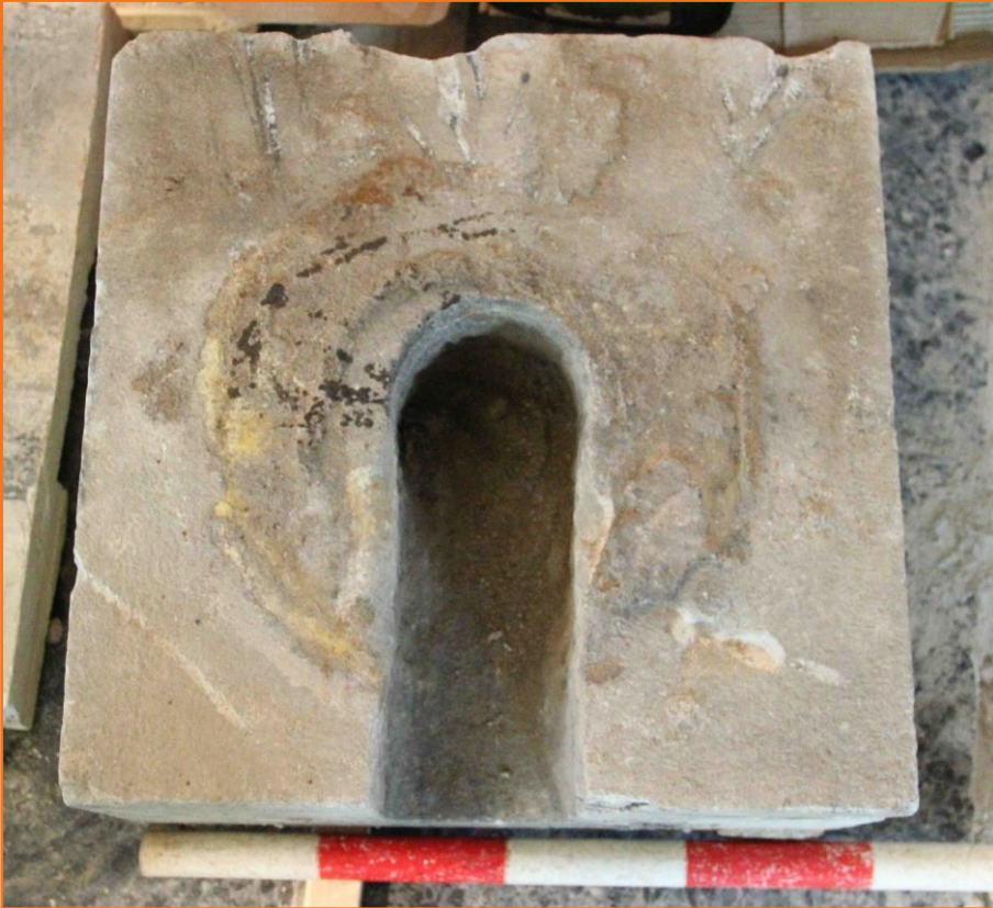
Foto 21. Detall de la pedra de l'embornal UE 36, un cop extreta, amb la marca d'òxid de ferro del morrió de ferro superior desaparegut. C3.
