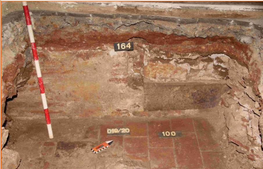
Foto 29. Vista de l'alçat del mur UE 164, amb la porta al costat dret, tapiat per la UE 165, amb el paviment UE 100. C4.
